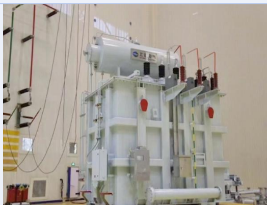
HSSPZ-80000/35 大型三相有载调压电弧炉 变压器
